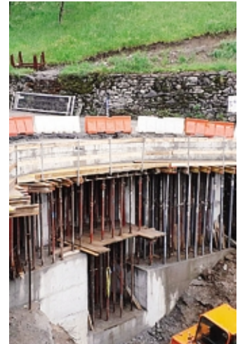
Il cantiere sulla sp 58
